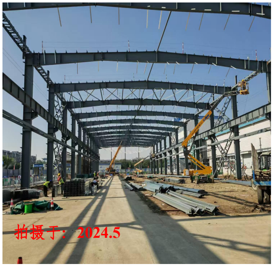
车间施工现场照片
