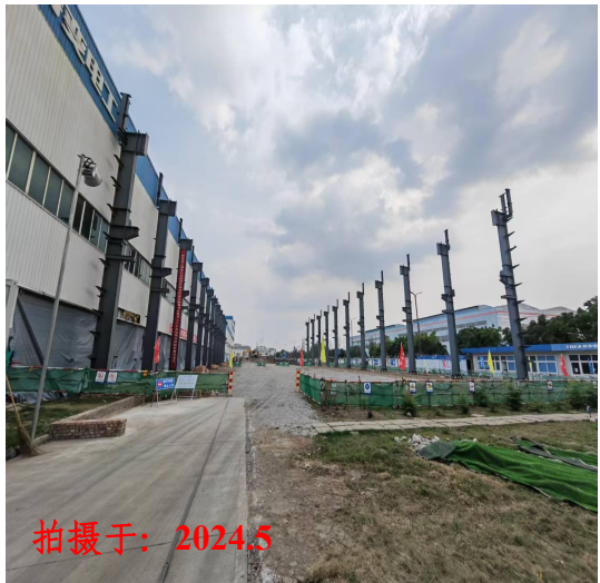
厂房施工现场照片
