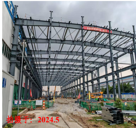
临时苦盖现场照片
