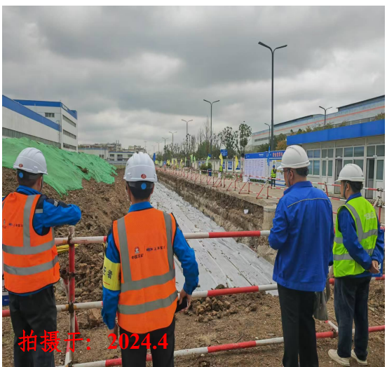
临时苦盖现场照片
